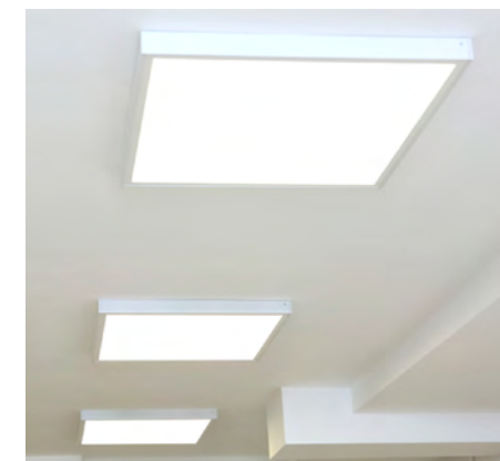
Lắp đặt ốp nổi
